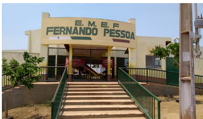
Figura 03 – Escola localizada no Residencial dos Minérios, em Parauapebas (2018)
