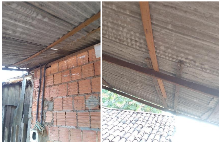
Figuras 6, 7 e 8: Registro da residência analisada.
