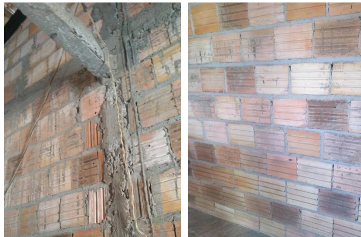
Figuras 2 e 3: Registro da residência analisada.
