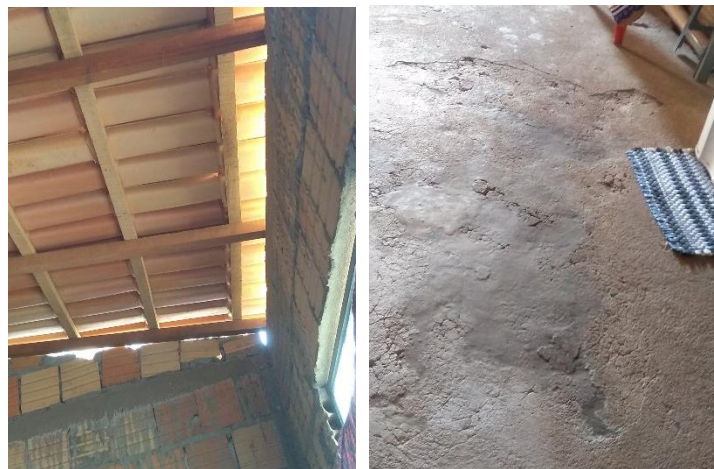
Figuras 4 e 5: Registro da residência analisada
