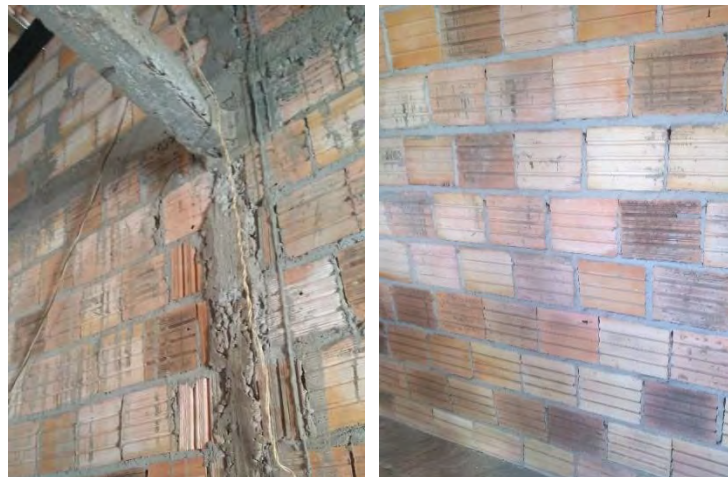
Figuras 2 e 3: Registro da residência analisada.
