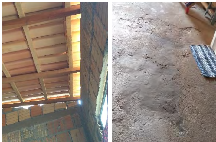
Figuras 4 e 5: Registro da residência analisada
