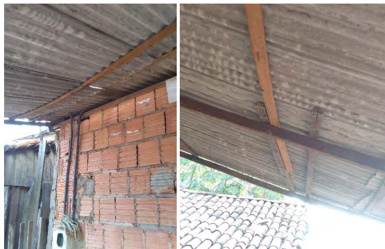
Figuras 6, 7 e 8: Registro da residência analisada.
